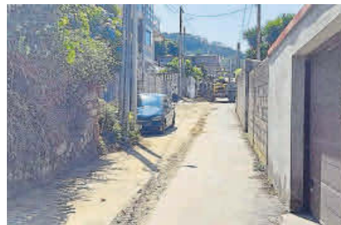
Las obras en la calle Cubela, en Bueu.
